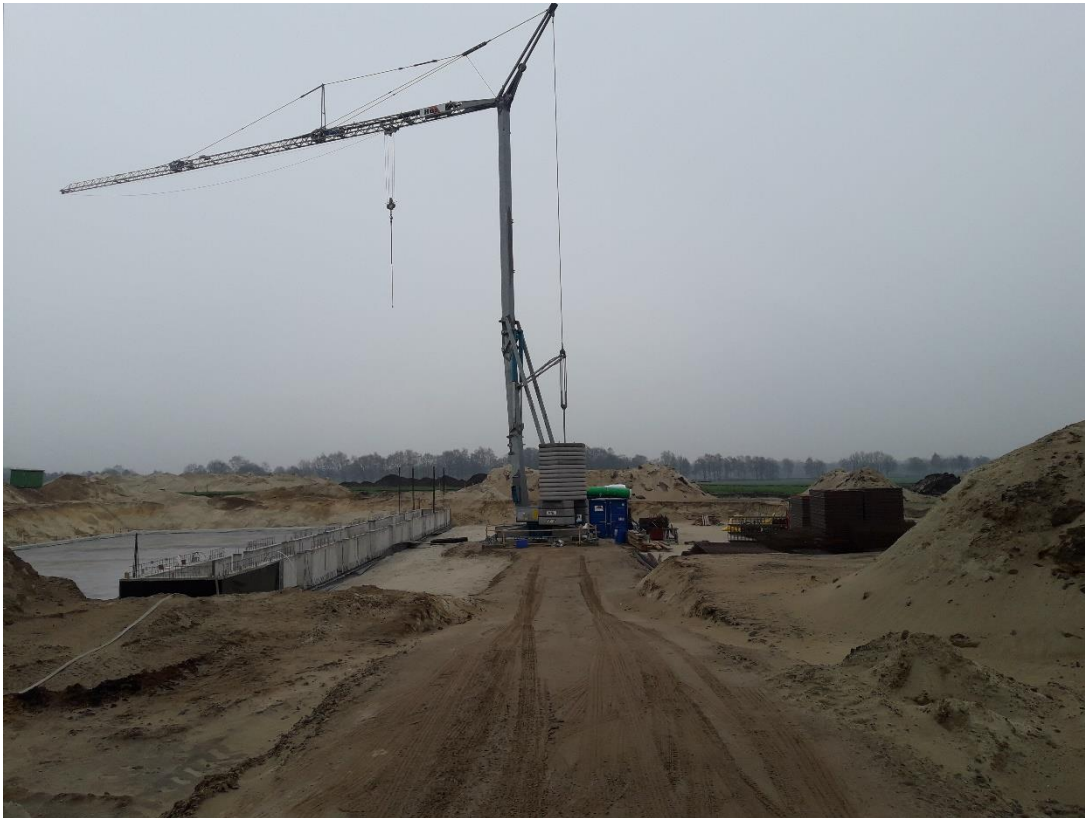
Abb. 2 Blick vom Westrand des EGs in die zentrale Eingriffsgebietsfläche hinein auf die Baustelle (Quelle: Büro Sinning, aufgenommen am 04.04.2019)
